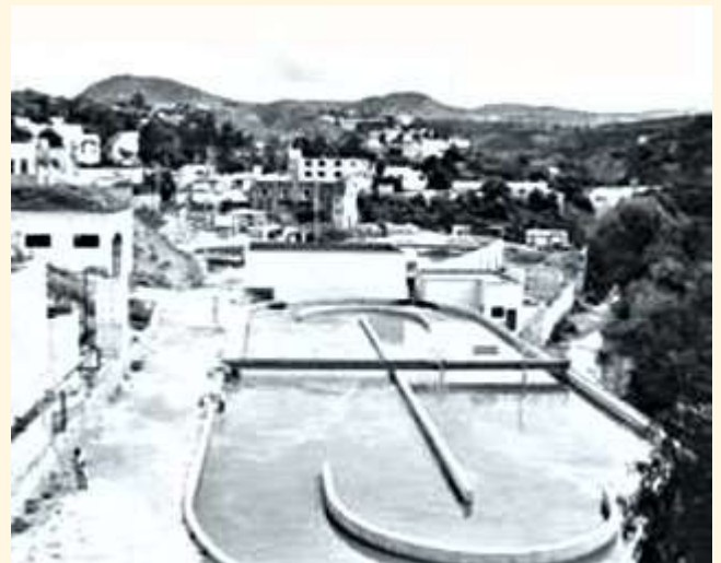
Vista geral da Estação de Tratamento em Guanajuato, México. Foto: Paula Silva-Ochoa
