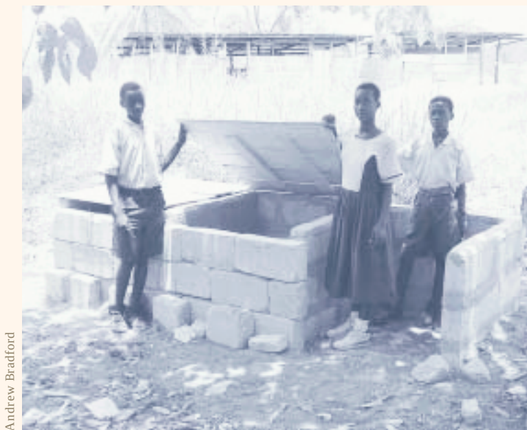
Cámara de compost triple construida con bloques, usada en la escuela secundaria Apeadu Junior, Kumasi
