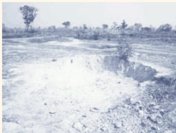
‘Hoyo’ preparado en el campo de cultivo para el almacenamiento y secado de lodos fecales
