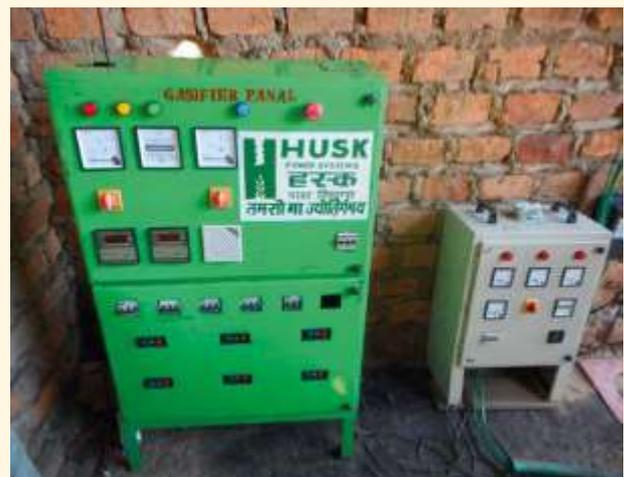
*Equipamento de controle do gaseificador
