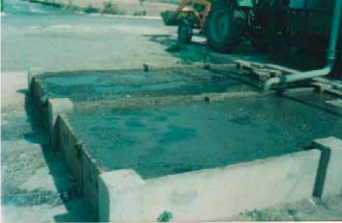
مسابك تجفيف الحمأة
