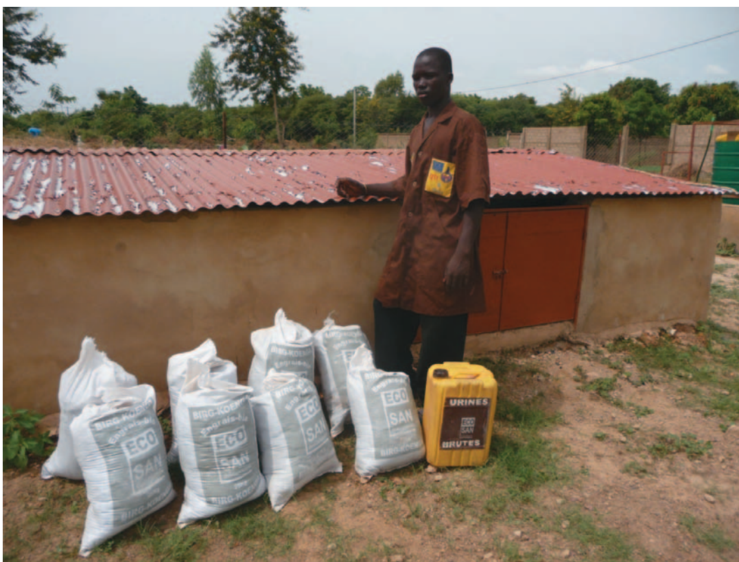
Ouedraogo Ablassé à l'ecostation du secteur 27 avec un peu d'engrais solide et liquide dans les chambres de stockage pour excréments séchés
