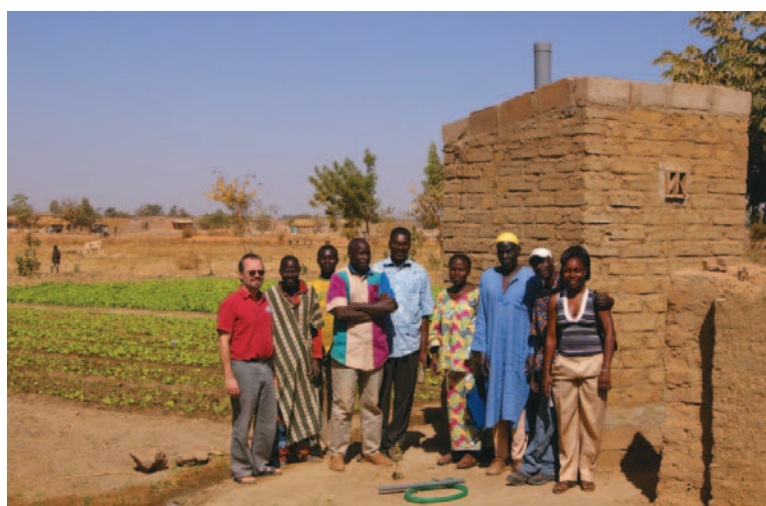
Toilette à double voûte avec superstructure de brique d'adobe (Photo : Linus Dagerskog, CREPA)
