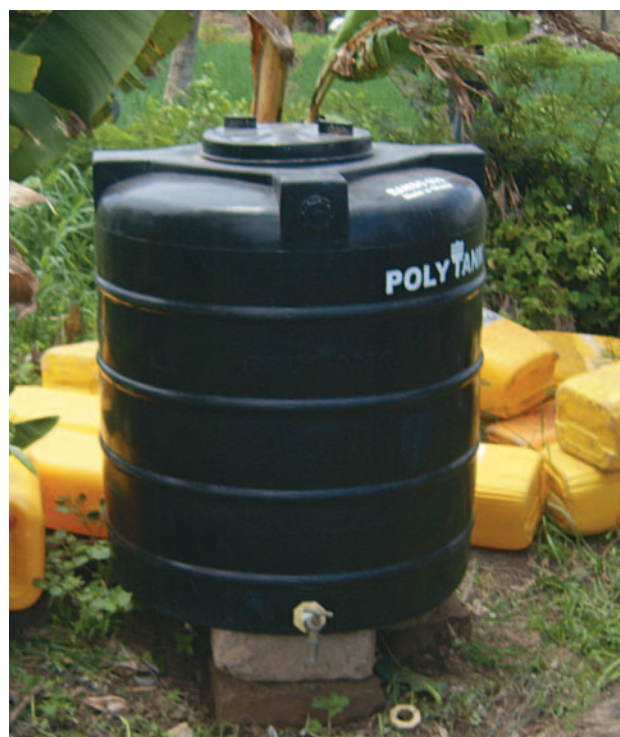
Réservoirs de stockage d'urine au site de test à Accra (Photo : René van Veenhuizen)
